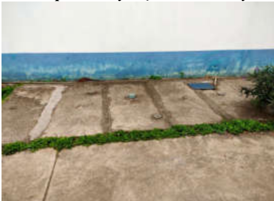
Bể tách dầu mỡ nước thải nhà ăn
